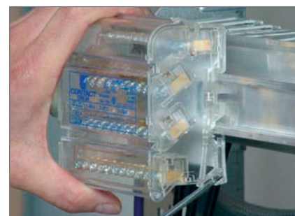
Morsettiere in un quadro elettrico. Distribution block in an electrical panel.
