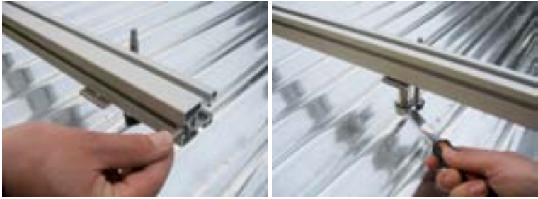
FASE 2 - Inserire le viti nella guida inferiore del profilo e fissare all'ancorante STEP 2 - Insert the screw in the guide of the profile and fix it to the fastener
