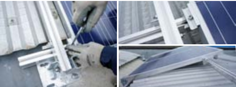
FASE 4 - Fissare il pannello STEP 4 - Fix the module
