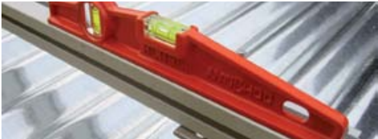
FASE 3 - Verificare l'allineamento STEP 3 - Check the alignment
