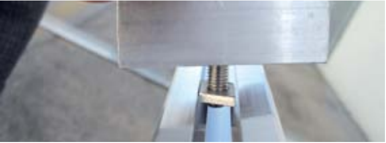
FASE 3 - Inserire i morsetti STEP 3 - Insert the clamp
