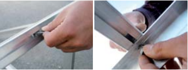
FASE 2 - Inserire le viti nella guida inferiore del profilo e fissare al triangolo STEP 2 - Insert the screw in the guide of the profile and fix it to the triangle
