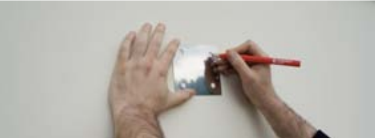
FASE 1 - Segnare punti di fissaggio delle piastre STEP 1 - Mark the point's plates
