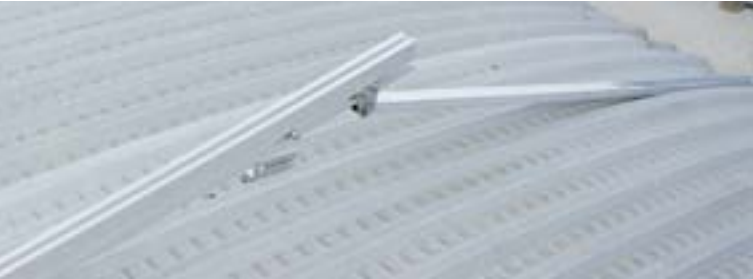
FASE 2 - Regolare/Fissare cavalletto KSC1550 STEP 2 - Regulate/Fix KSC1550
