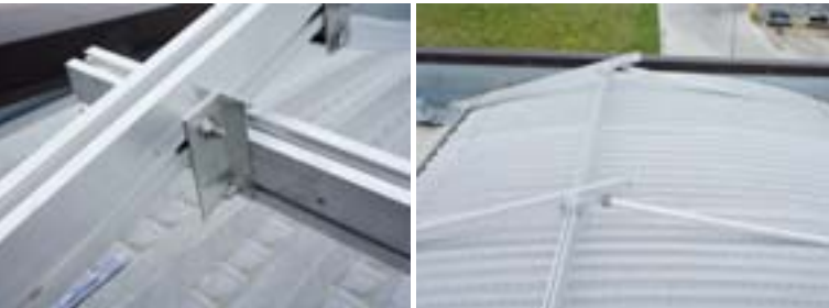
FASE 3 -Fissare profili di supporto moduli PRT5908 STEP 3 - Fix profiles PRT5908 to support modules
