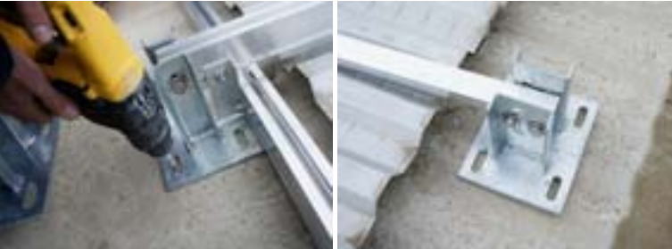
FASE 1 - Fissare staffa anteriore e posteriore sul piano inclinato della trave ad Y STEP 1 - Fix the brackets on Y beam
