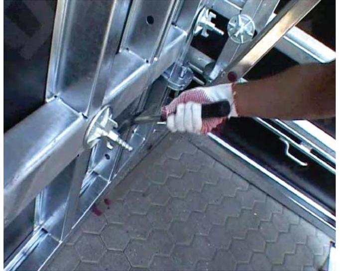
36. Fissaggio delle barre ancoranti
