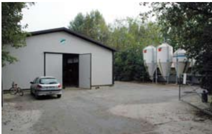
Figura 5. Zona pavimentata in cemento esterna all'allevamento per le operazioni di carico e scarico
