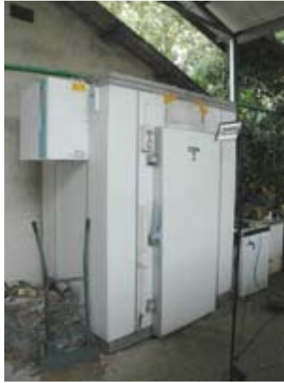
Figura 6. Frigorifero per la raccolta delle carcasse degli animali deceduti. La posizione a ridosso del capannone non è una soluzione ottimale e consigliata.
