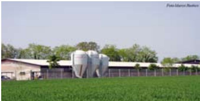
Figura 16. Silos posti lungo la cinta caricabili dall'esterno
