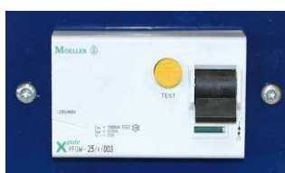
Fusibile 25 A D-curvo, 30 mA Interruttore di perdita della terra
