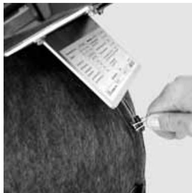
Figura 8-2 Rimozione della clip di fissaggio dei gusci isolanti
