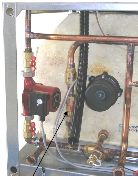
Absperrkugelhahn in der Doppelt-Differenzdrucklosen Verteilung
