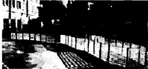
Fasi previste : montaggio manuale di tali elementi cm. 350 x 200 previa collocazione di basamenti di ancoraggio. Installazione lungo il perimetro di idonea illuminazione di sicurezza notturna con lampade rosse in bassa tensione
