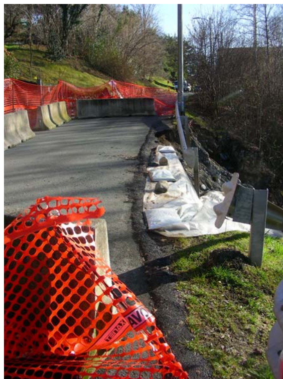
Particolare attuale area dei lavori
