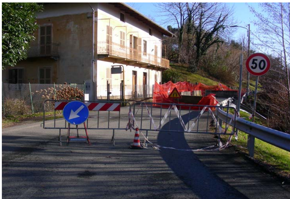
Particolare strada chiusa e cartellonistica posizionata
