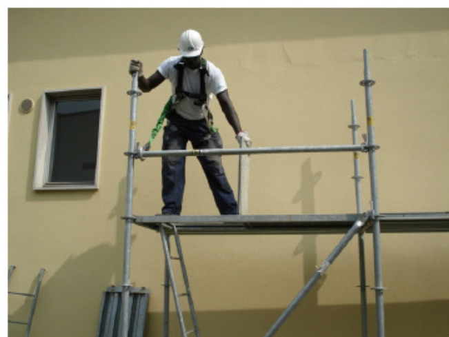
16) Assicurarsi al corrente inferiore montato e chiudere la tavola con botola
