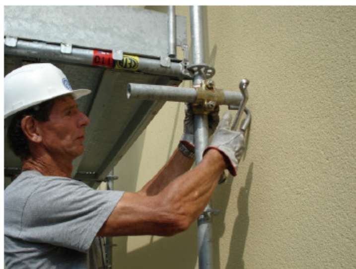
20) Montare gli ancoraggi al primo livello, secondo gli schemi del libretto di autorizzazione o come indicato nel progetto
