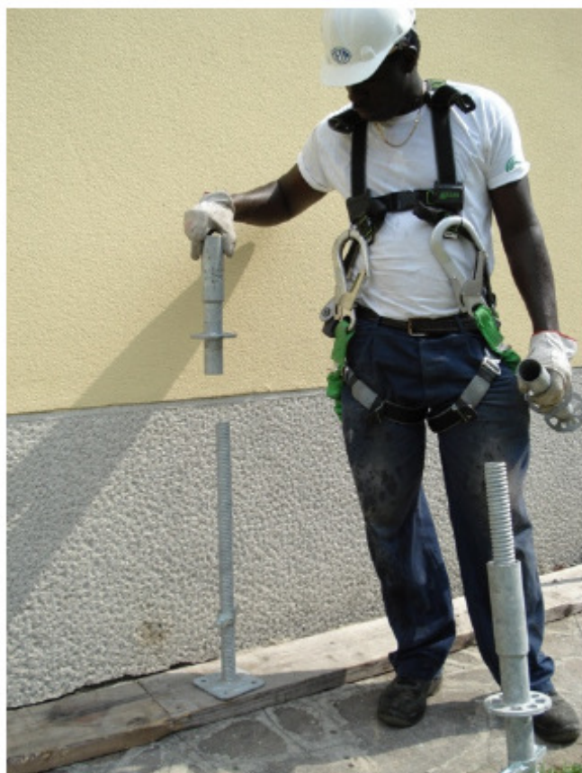
2) Infilare l'elemento di partenza
