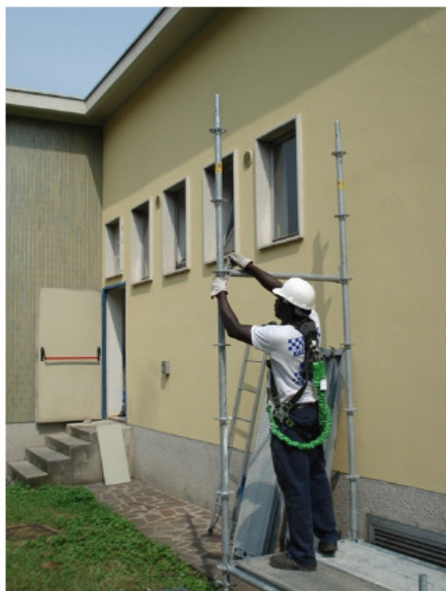
8) Montare i traversi ad altezza 2 metri
