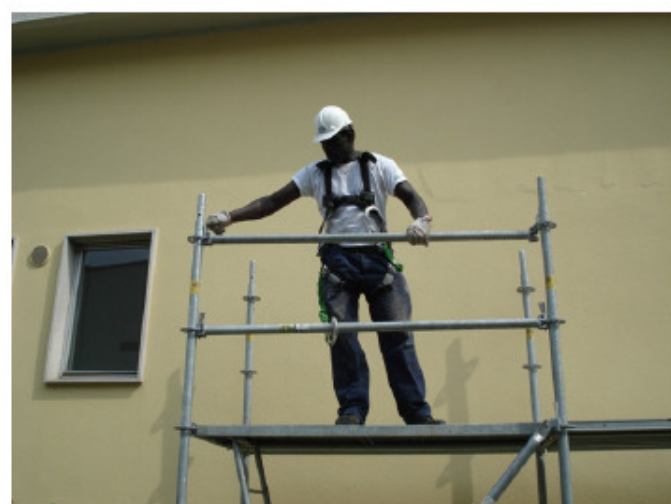
17) Montare il corrente superiore
