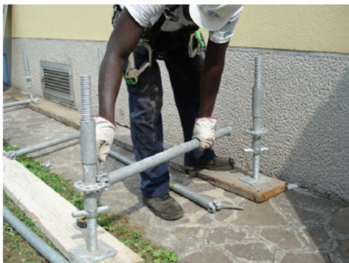
3) Montare il traverso, infilando la baionetta nella rosetta
