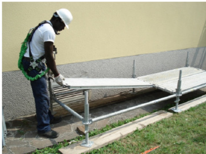
5) Montare il piano metallico sul lato interno del ponteggio
