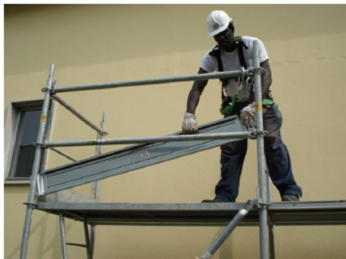
19) Completare l'impalcato con il fermapiede
