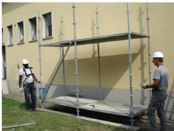
12) Allineare la struttura e fissare le basette alle tavole in legno sottostanti
