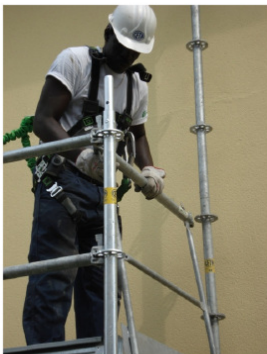
18) Montare il telaio di testata
