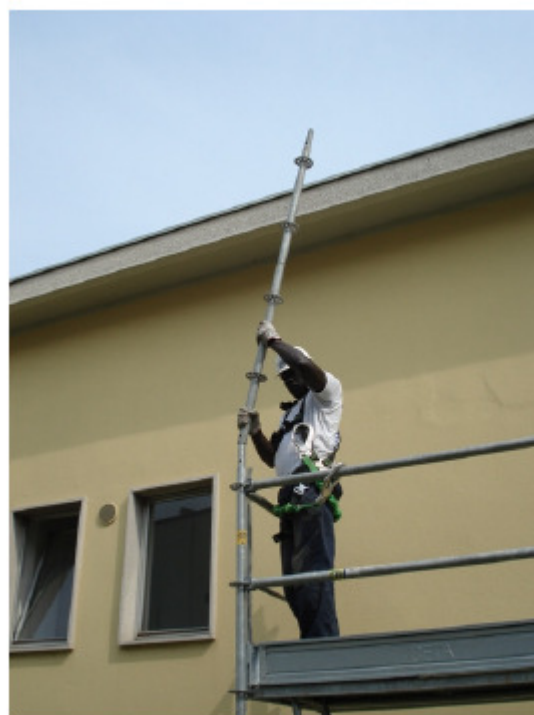
21) Infilare i montanti da 2 metri
