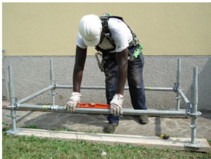
6) Mettere in bolla il ponteggio
