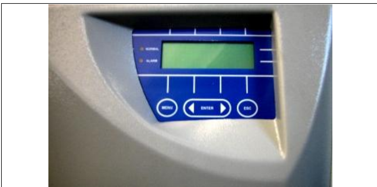
Figura 0-1 Pannello di controllo UPS
