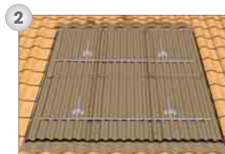
**2)** Ancoraggio delle converse e della carpenteria di fissaggio dei collettori.
