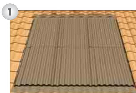
**1)** RIMOZIONE DELLA CARPENTERIA E POSIZIONAMENTO DELLE CONVERSE NELLO SPAZIO NECESSARIO ALL'INSTALLAZIONE.
