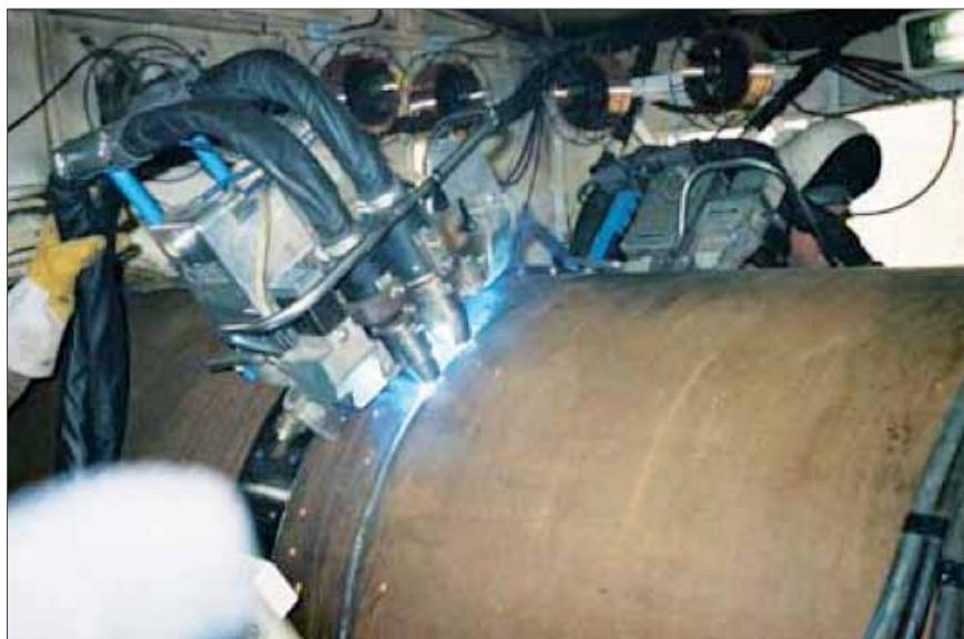
Figura 2 - Saldatura GMAW con quattro torce, tubazione in acciaio X100 e diametro 52".
