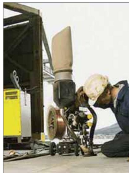
Figura 16 - Saldatura con tecnica a forte penetrazione di un giunto longitudinale di un ponte.
