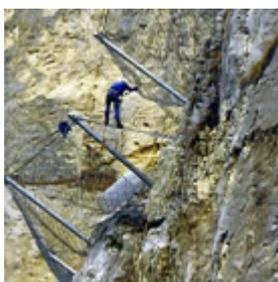
Si tratta di un intervento atto a creare una valida protezione passiva contro la caduta di pietre. Lo schema strutturale garantisce la trasformazione delle eventuali forze a cui potrebbero essere sottoposte a causa della caduta di massi, in deformazioni plastiche o plastico-transitorie controllate.
