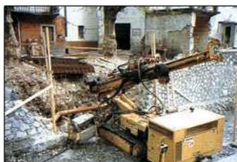
Trattasi della realizzazione di micropali inclinati per sottofondazione con armatura costituita da tubi d'acciaio valvolati o in tondini di acciaio ed iniezione di malta cementizia.
