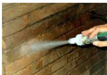
Trattasi dell' intervento di sabbiatura con sabbia silicea o quarzifera su pareti verticali o orizzontali, rette o curve, per murature di mattoni o di pietra, con aggiunta, all'ugello di uscita, di acqua per inumidire l'abrasivo.
