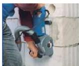
*Trattasi della formazione di tracce in muratura di qualsiasi natura per l'alloggiamento di tubazioni in genere, compreso la chiusura al grezzo delle tracce stesse.*
