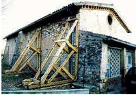
Trattasi della esecuzione di puntellature in legno o metalliche di pareti, solai, volte, tetti, mediante assemblaggio di elementi portanti quali: murali, tavole, croci, gattelli, tubi.
