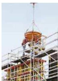
Per la realizzazione di strutture in c.a., si può anche usare calcestruzzo prodotto in cantiere, mediante l'ausilio di benna a secchione (per i cantieri di piccole dimensioni sprovvisti di un sistema di pompaggio) oppure mediante l'utilizzo di pompa per CLS. In generale, l'esecuzione del getto di conglomerato cementizio avviene secondo le seguenti modalità:
