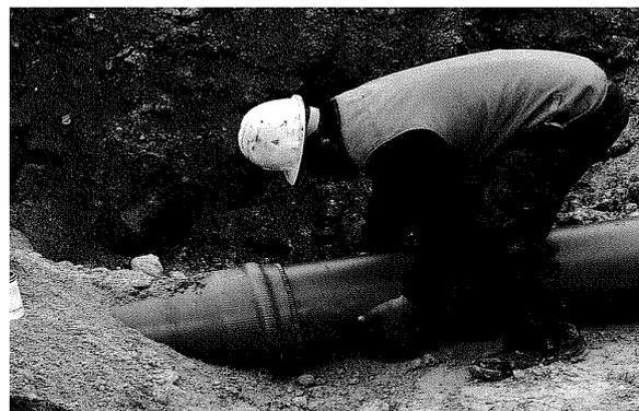
protezione, l'altro per la rimozione degli stessi, la posa dei tubi ed il rinfianco con sabbia, per la rimozione delle paratie di armature gli stessi e la chiusura degli scavi a posa ultimata.
