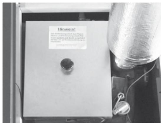
Fissare in sede il rivestimento della parte superiore della caldaia.
