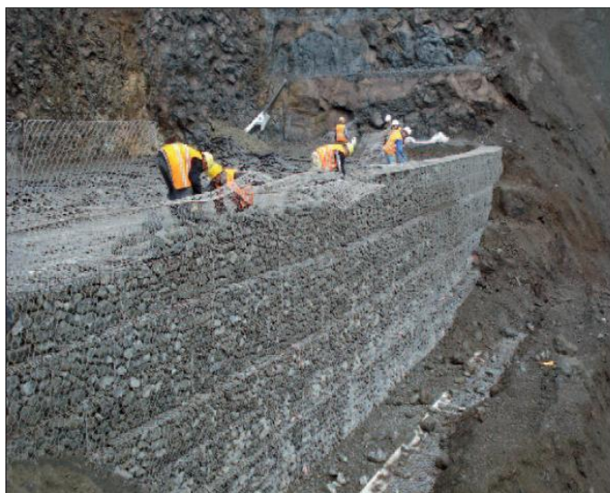
- tecnica delle terre rinforzate
