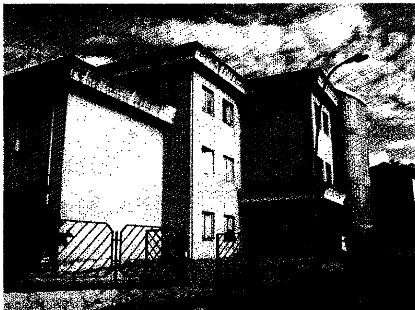
Vista frontale d'angolo: dietro la scuola elementare si vede la scuola media di C.A., costruita in aderenza.
