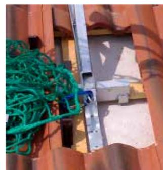
Con il parapetto Solartec si può mettere in sicurezza, in modo facile e veloce, un tetto in legno inclinato da 20° a 60°. Per depositare degli attrezzi può essere appoggiata una tavola di larghezza massima 28 cm sul supporto Solartec. Grazie al ridotto spazio d'ingombro può essere utilizzato per qualsiasi opera di ristrutturazione:
