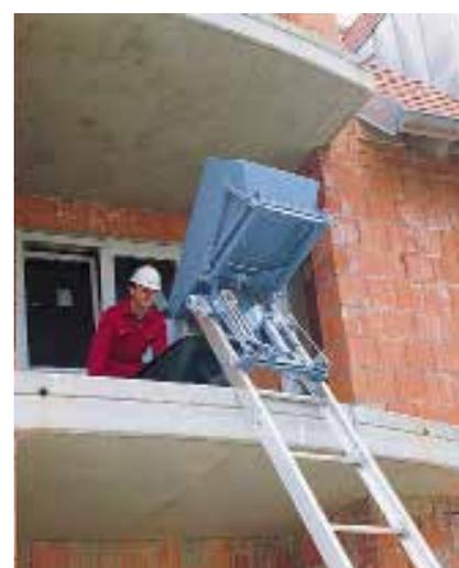
Per portare in quota materiale sciolto (sabbia, ghiaia ecc.) GEDA offre una soluzione comoda, ossia la **piattaforma con cassone ribaltabile** completa di guida di ribaltamento con puntoni di sostegno, che viene montata al posto dell'elemento di testa standard. Il cassone ribaltabile, prolungando la corsa del carrello, si gira di 130°, svuotandosi automaticamente.
