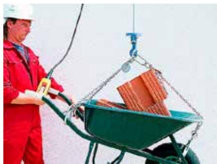
L'argano GEDA può essere utilizzato non solo per sollevare elementi di ponteggio, ma anche per materiale necessario durante le opere di ristrutturazione e costruzione di un edificio. Accessori, come le **catene di sollevamento** registrabili in lunghezza, permettono di alzare qualsiasi materiale in quota (es. carriole).
