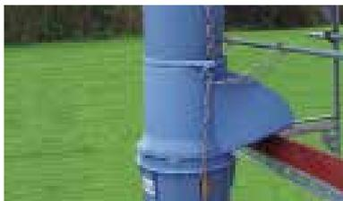
Con la **tramoggia di carico intermedia** è possibile lo scarico di detriti anche da diversi piani dell'edificio. Dotata di ganci e catene in acciaio zincato per il collegamento ai convogliatori.
