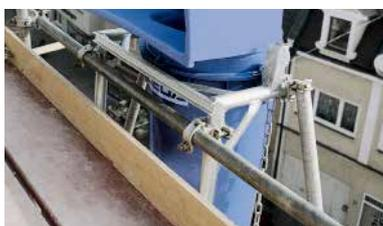
I convogliatori di materiale vengono utilizzati nella maggior parte dei casi durante costruzioni o restauri dove esiste un ponteggio. Il **telaio di fissaggio** permette l'aggancio del convogliatore al ponteggio utilizzando semplici morsetti.
