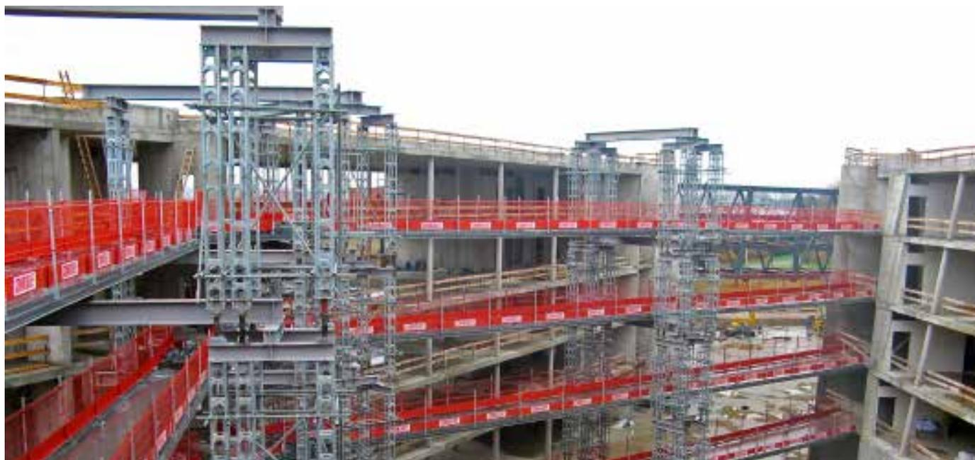
Oltre ai sistemi di prevenzione di caduta laterali di tipo collettivo, Combisafe offre anche sistemi di arresto caduta.
