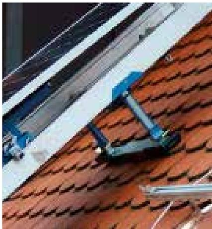
Il **cavalletto di appoggio** regolabile è ideale per appoggiare il montacarichi GEDA su qualsiasi tipo di copertura inclinata, senza rovinare la stessa.
