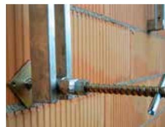
**Regolazione barrasponda:** la distanza tra barrasponda e muro dell'edificio, dev'essere regolata il più preciso possibile tenendo conto dello spessore della tavola da getto per poter posare la barra sponda a piombo del muro.
