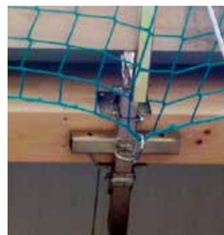
Le due versioni di montaggio del parapetto Kombi, permettono di mettere in sicurezza tutto il perimetro di un tetto in legno a falde con un unico prodotto. Il prodotto è interamente in acciaio zincato ed è certificato secondo la normativa europea UNI EN 13374 classe C.
