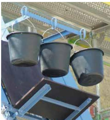
Per portare in quota materiale sciolto in contenitori è disponibile il **sostegno di aggancio secchi**, che viene semplicemente agganciato alla piattaforma universale e può trasportare fino a 3 secchi di misura media.
