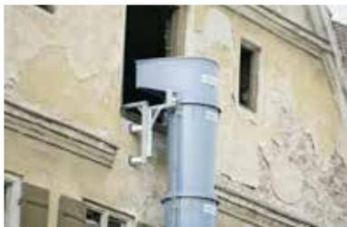
Con la **tramoggia di carico** a forma di imbuto, i detriti di cantiere possono essere svuotati direttamente con la carriola nel convogliatore, evitando fuoriuscite di materiale.
