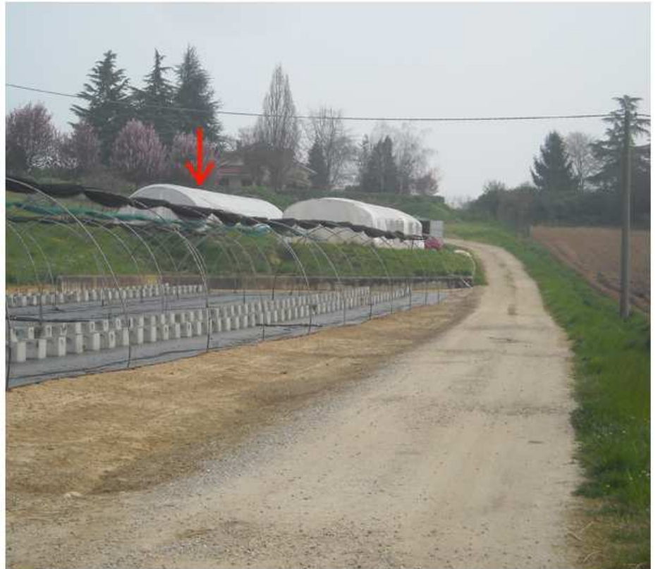
Foto 2 Visuale dalla strada interna all'Istituto sulla serra da demolire per fare posto alla serra in progetto.
