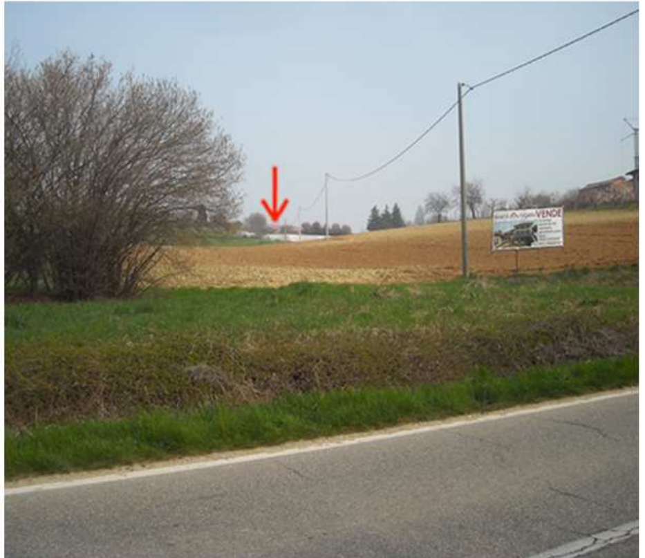
Foto 1 Visuale dalla strada provinciale Chieri-Pecetto sulla serra da demolire per fare posto alla serra in progetto.
