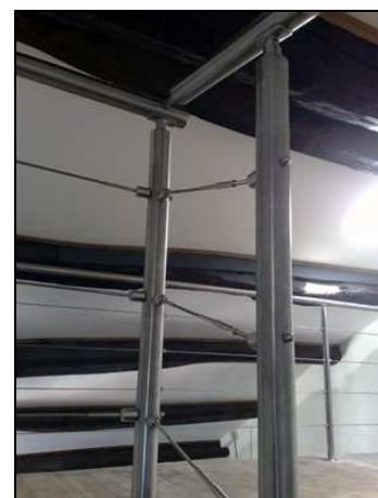
Con i terminali rapidi della serie **TECNOFUNI SUPER INOX** le funi per ringhiere e scale possono essere preparate direttamente dall'utilizzatore finale, senza necessità di pressature e macchinari vari, semplicemente eseguendo il fissaggio del terminale rapido all'estremità della fune servendosi dell'apposito cono per il bloccaggio della stessa. Tali terminali presentano una forma molto curata dal punto di vista estetico, ed una notevole robustezza.
