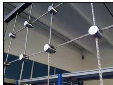
I morsetti ad incrocio della serie *TECNOFUNI.ARCHI-INOX* possono essere anche utilizzati nei sistemi in fune d'acciaio per ringhiere e balaustre, fungendo da elementi decorativi per impreziosire l'intera architettura della struttura.
