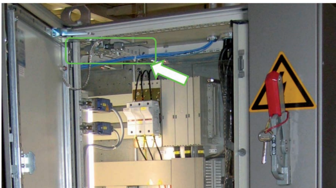
Esempio di interblocco meccanico con chiavistello
