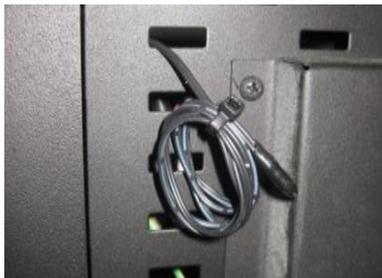
Figura 20- Sonda di temperatura ambiente
