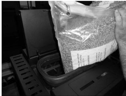
Figura 26 – Rabbocco del vano pellet
