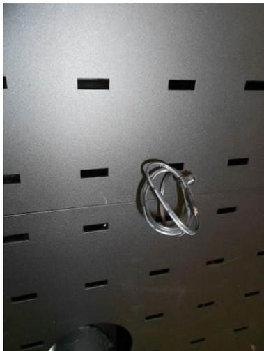
Figura 9 - Sonda di temperatura ambiente
