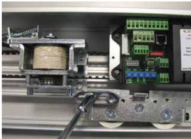
Collegare il blocco al quadro elettronico [2] mediante il cablaggio in dotazione.
