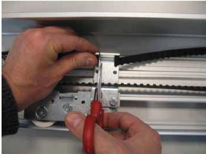
Inserire la cinghia nella staffa attacco cinghia [8] come indicato in figura, e bloccarla mediante l'apposita staffa bloccaggio cinghia.
