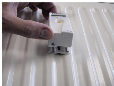
Fig. 5.1.2.5 Fissaggio dello strumento sul conduttore di calore
