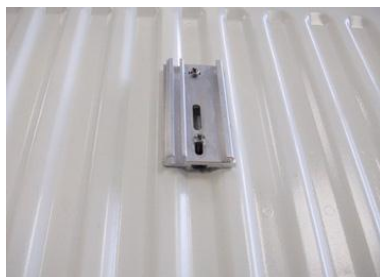
Fig. 5.1.2.1 Fissaggio della piastra di accoppiamento termico
