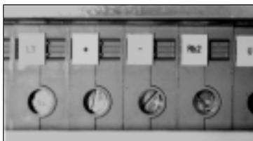
La sezione dei conduttori da impiegare per i morsetti + e Rb2 della morsettiera X1 è tra 16 e 50 mm<sup>2</sup>.
