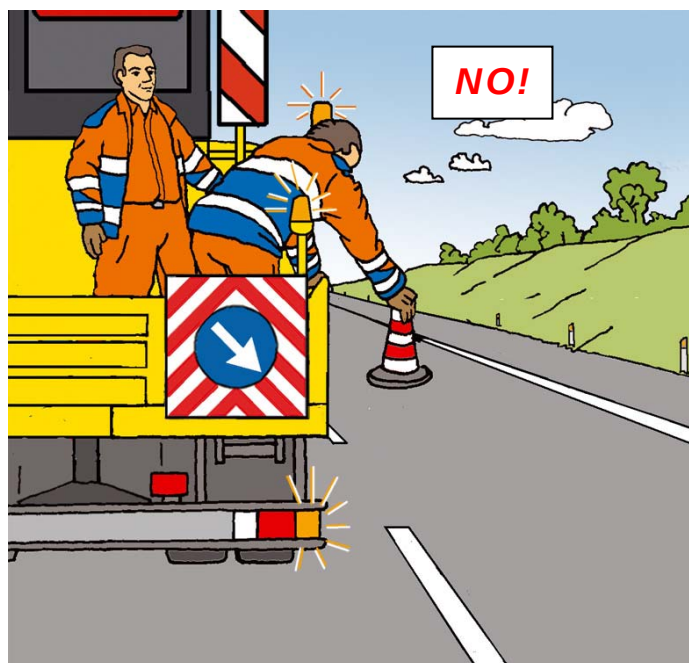
Figura 49 – Posizionamento dei coni o defleco: comportamento scorretto
