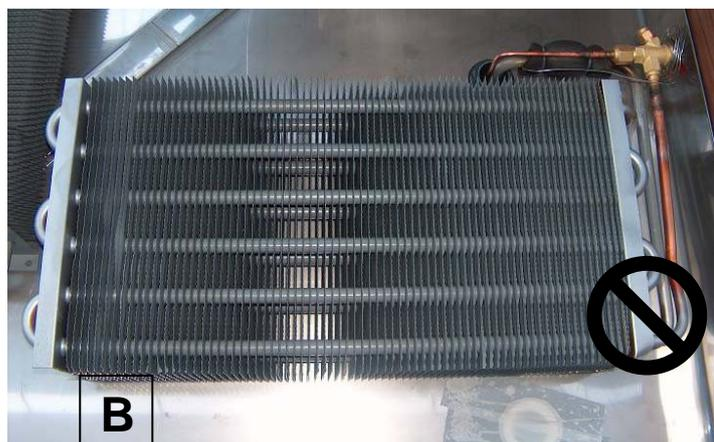
Fig. 5: identificazione curva (solo in mancanza di valvola di carico)
