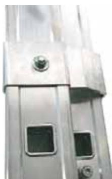
Le cerniere di scorrimento e tenuta sono in estruso di alluminio. Un perno di sicurezza impedisce l'elevazione di trabattello e scala oltre l'altezza consentita.
