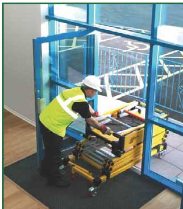
Cigno è strutturato con un ingegnoso sistema a molle che consentono all'operatore di aprire il trabattello fino a m 3,00 con una leggera spinta verso l'alto.
