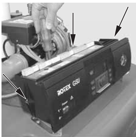
Fig. 5-14 Rimozione dei tappi a vite della copertura del quadro di comando
