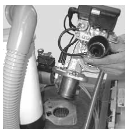
Fig. 6-8 Rimuovere il bruciatore
