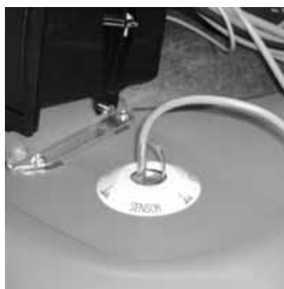
Fig. 5-13 Sonda di temperatura dell'accumulatore con molla di compressione
