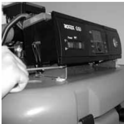
Fig. 5-9 Allentare le viti di fissaggio del quadro di comando della caldaia
