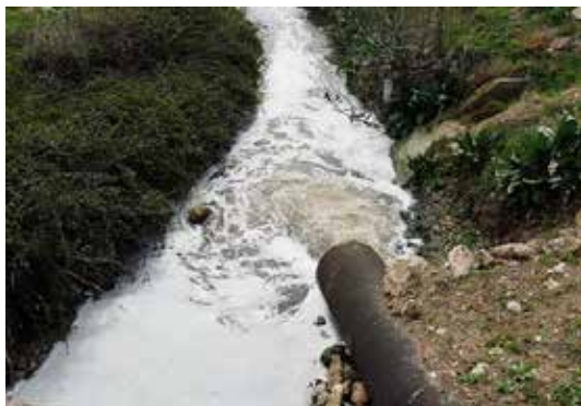
DEPURAZIONE Tubo riveniente dall'impianto di Jesce, in agro di Altamura
