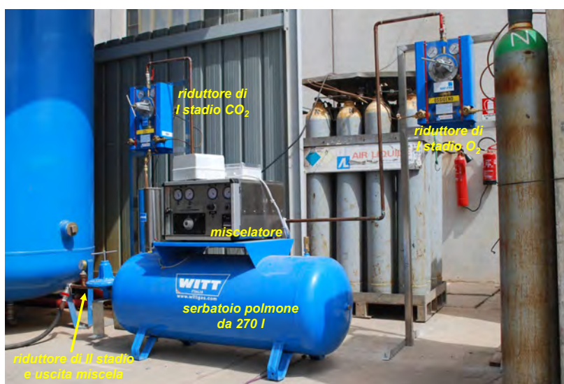
Figura 37. Sistema di miscelazione di \text{O}_2 e \text{CO}_2
