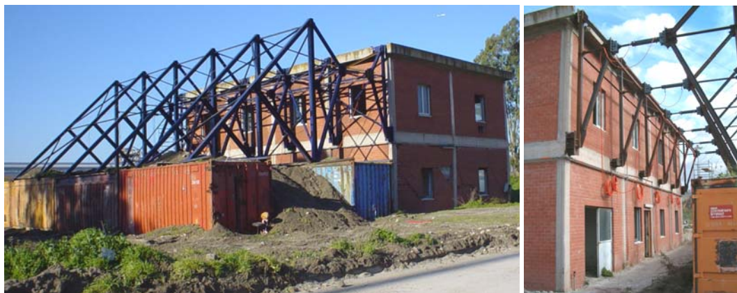
Fig. 6.12: Strutture di contrasto e di ripartizione del carico.
