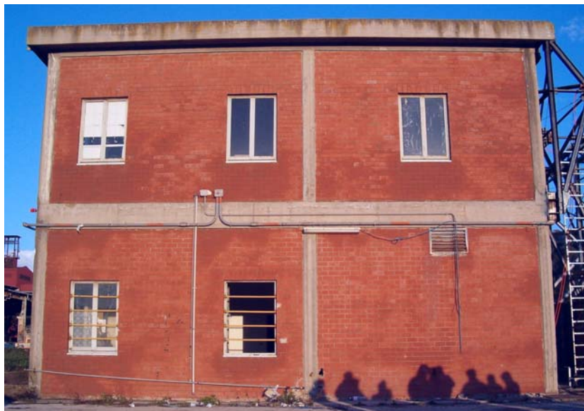
Fig. 6.18a: III ciclo di carico (punto A): Vista del prospetto ovest.
