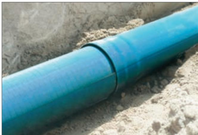
Fig. 13-33 Posa del drenaggio sul campo da gioco
