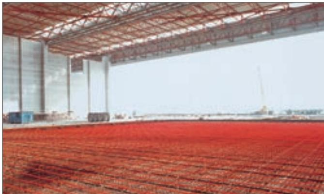
Fig. 13-1 Riscaldamento a pavimento in un capannone industriale
