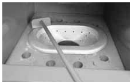
Pulizia camera combustione con rastrello
