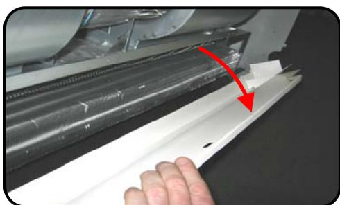
Ora il vassoio di raccolta della condensa s'inclina lungo il suo bordo anteriore per permetterne la pulizia. Rimuovere tutto lo sporco dal vassoio, dagli scarichi e dal tubo flessibile di drenaggio della condensa.
