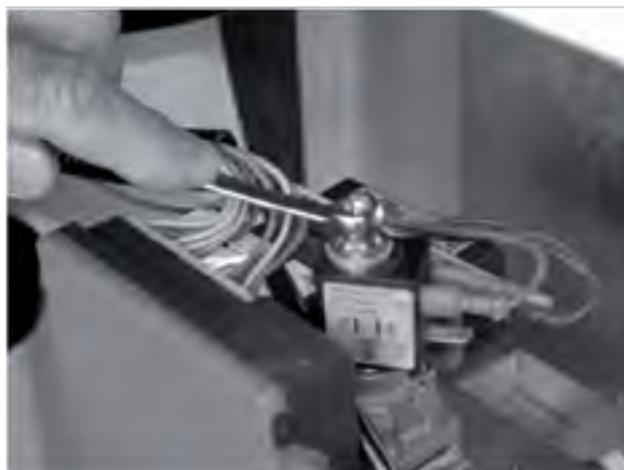
Verificare e, se necessario, regolare la pressione in uscita della valvola su 8,4 mbar minimo (G20) / 12,3 mbar per gas Groninga (G25) e 31,4 mbar per propano (G31).
