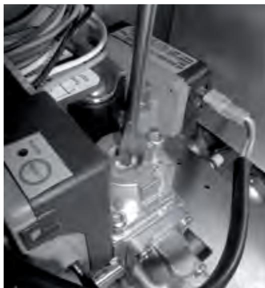
Verificare e, se necessario, regolare la pressione in uscita della valvola su 8,4 mbar (G20) (o 12,3 mbar per G25)
