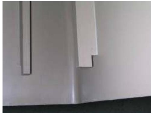
Il condotto dell'aria deve essere fatto calzare all'interno dell'imbocco dell'apparecchio previsto nella parte inferiore ed entrare nel raffrescatore per 30 mm.
