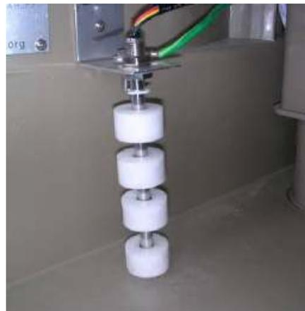
In modalità 'COOL' l'acqua entra nel pozzetto, con entrambe le valvole di entrata aperte, fino alla copertura della sonda di livello alto. Quindi, la valvola di entrata V1 si chiude. In seguito l'acqua evapora finché la sonda livello basso è scoperta. La valvola V1 si apre (V2 è già aperta) e si riempie fino al livello alto quando V2 si chiude.
