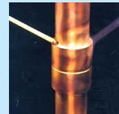
*Prima di eseguire delle saldature, smontare il tappo-targhetta della valvola del gas da 1/2" ed eliminare completamente l'azoto caricato in precedenza.*
