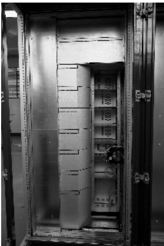
Esempio di quadro con forma 4 realizzato a regola d'arte
