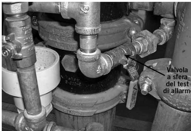
5. Dopo aver verificato il corretto funzionamento di tutti gli allarmi, chiudere la valvola a sfera del test di allarme.
