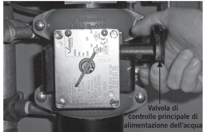
5. Aprire lentamente la valvola di controllo principale dell'acqua di alimentazione, finché una piccola quantità di acqua non fuoriesce attraverso la valvola di drenaggio principale dell'acqua di alimentazione.
