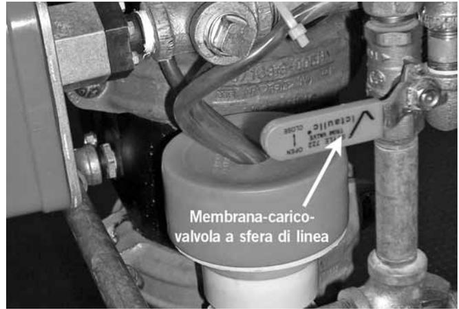
9. Chiudere la membrana-carico-valvola a sfera di linea.
