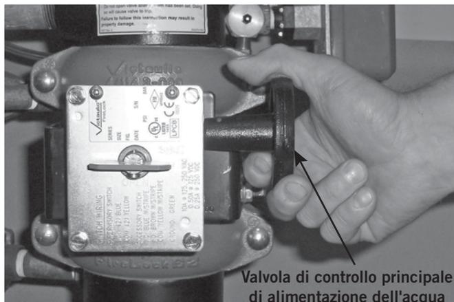
**OGNI SETTIMANA, QUANDO LA VALVOLA VIENE RIPRISTINATA IN SEGUITO A UN TEST OPERATIVO (O DOPO QUALSIASI OPERAZIONE DEL SISTEMA):** La valvola di drenaggio principale e le eventuali valvole di drenaggio a valle devono essere parzialmente aperte e poi chiuse per drenare l'acqua che potrebbe essere presente nel montante. Continuare questa procedura fino a scaricare tutta l'acqua.
