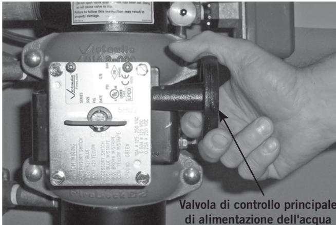
9. Chiudere completamente la valvola di controllo principale di alimentazione dell'acqua.
