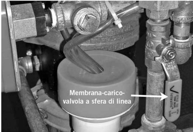
5. Aprire la valvola a sfera della linea di carico della membrana.
