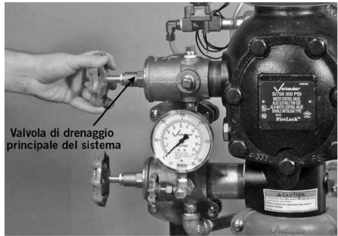
8. Chiudere la valvola di drenaggio principale del sistema.
