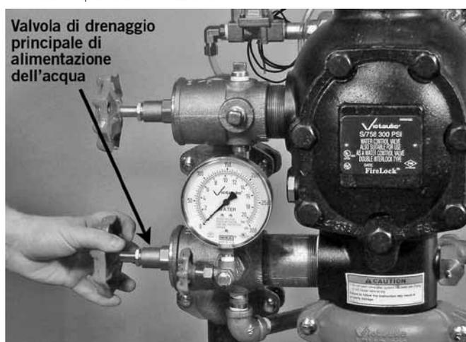
3. Chiudere la valvola di drenaggio principale dell'acqua di alimentazione.
