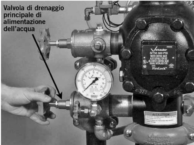
16. Quando il flusso dell'acqua è costante, chiudere la valvola di drenaggio principale di erogazione dell'acqua.
