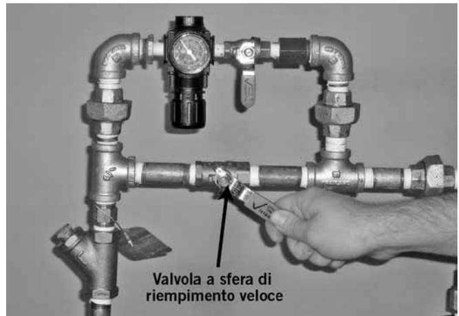
11. Caricare il sistema con aria, accendendo il compressore o aprendo la valvola a sfera di riempimento veloce sul dispositivo di mantenimento pressione aria (in alto è rappresentata la valvola a sfera di riempimento veloce). Caricare il sistema ad 13 psi/90 kPa/0,9 Bar. Fare riferimento alla sezione "Requisiti dell'aria di alimentazione".
