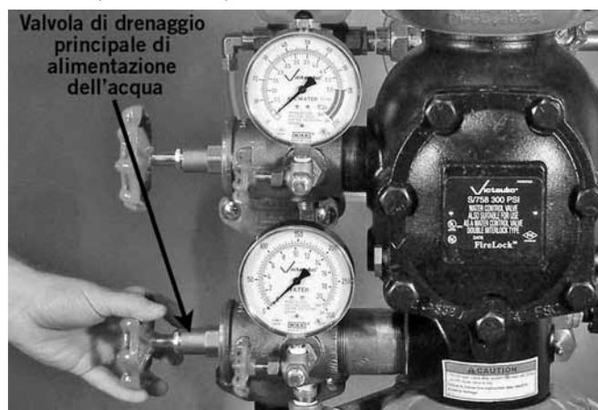
28. Quando il flusso dell'acqua è costante, chiudere la valvola di drenaggio principale di erogazione dell'acqua.
