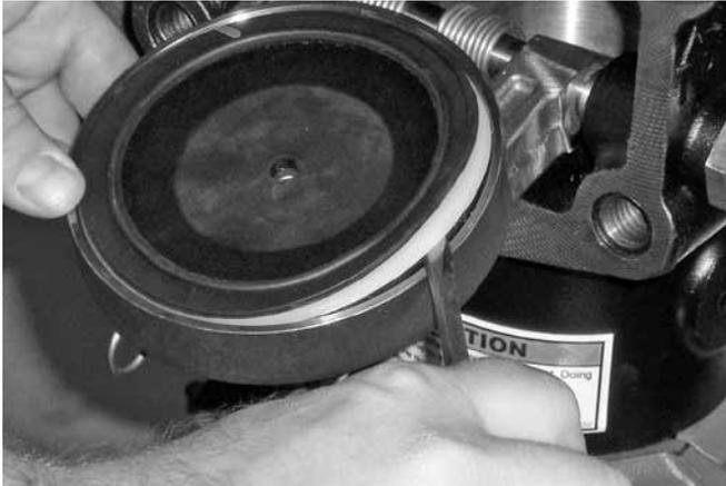
6. Fare leva sulla tenuta del clapet per farlo fuoriuscire insieme all'anello. Ispezionare la tenuta del clapet. Se la tenuta mostra segni di usura o danno, sostituirla con una nuova, fornita da Victaulic. Se si procede con la sostituzione dell'assemblaggio della tenuta del clapet, passare direttamente al punto 7.
