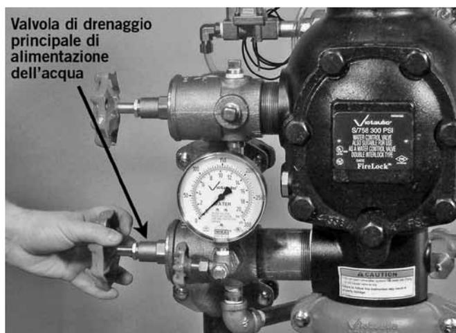
2. Aprire completamente la valvola di drenaggio principale di alimentazione dell'acqua per eliminare eventuali contaminanti dall'acqua di alimentazione.
