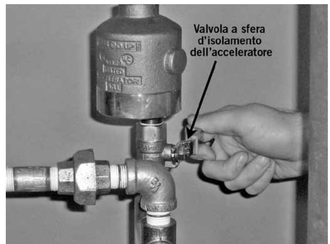
2. Se è installato un acceleratore a secco serie 746-LPA, chiudere la valvola di sfiato a sfera.
