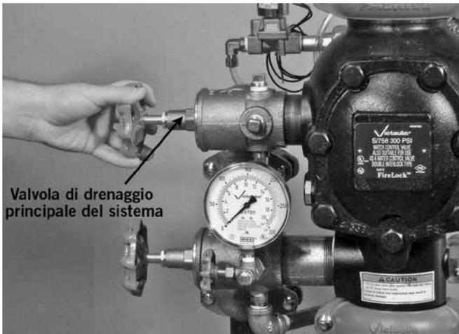
8. Aprire la valvola di drenaggio principale del sistema per drenare l'eventuale acqua accumulata e per scaricare la pressione dell'aria del sistema.
