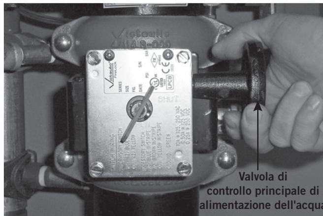
27. Aprire lentamente la valvola di drenaggio principale dell'erogazione di acqua, finché l'acqua non fuoriesce con un flusso costante.
