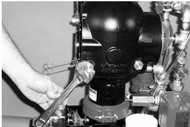
2. Rimuovere dal corpo della valvola le boccole dall'albero del clapet.
