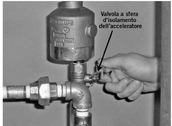
4. **PER SISTEMI INSTALLATI CON ACCELERATORE A SECCO SERIE 746-LPA:** Confermare che la valvola a sfera di isolamento verso l'acceleratore sia chiusa.
