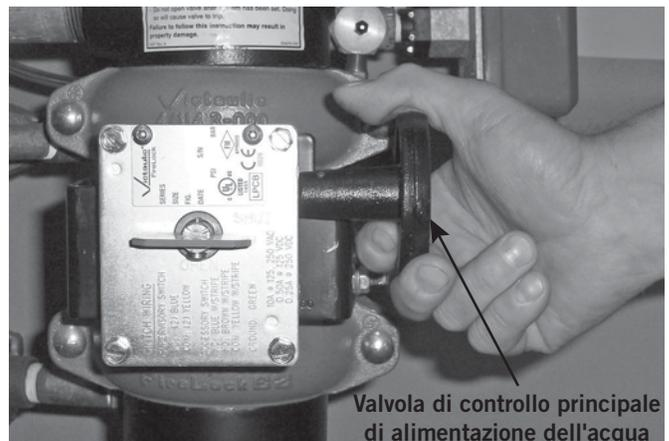
9. Chiudere la valvola di controllo principale di alimentazione dell'acqua.
