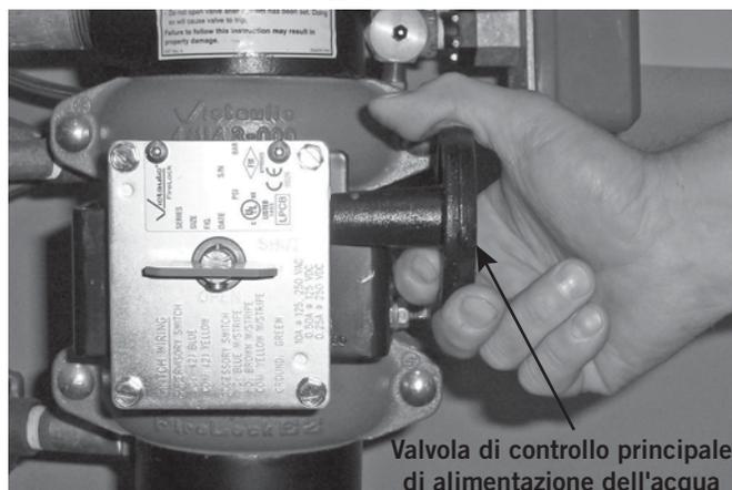
5. Chiudere la valvola di controllo principale di alimentazione dell'acqua.
