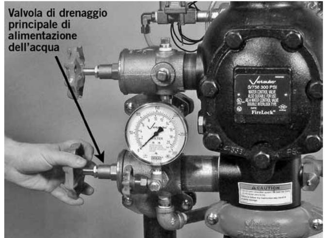
4. Chiudere la valvola di drenaggio principale dell'acqua di alimentazione.
