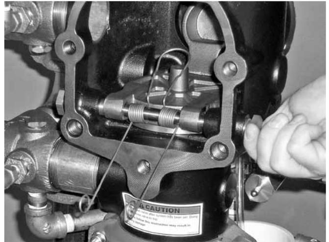
9. Applicare del sigillante per filettature sulle boccole dell'albero del clapet. Installare le boccole dell'albero del clapet nel corpo della valvola, con la forza delle sole mani.
