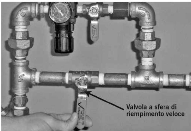
16. Quando la pressione dell'aria di sistema è stabilita, chiudere la valvola a sfera di riempimento veloce sull'AMTA.
