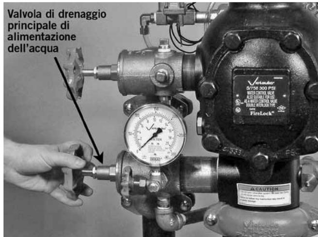
3. Aprire completamente la valvola di drenaggio principale di alimentazione dell'acqua per eliminare eventuali contaminanti dall'acqua di alimentazione.
