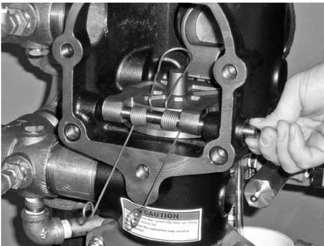
6. Inserire l'albero del clapet per metà nel corpo della valvola.
