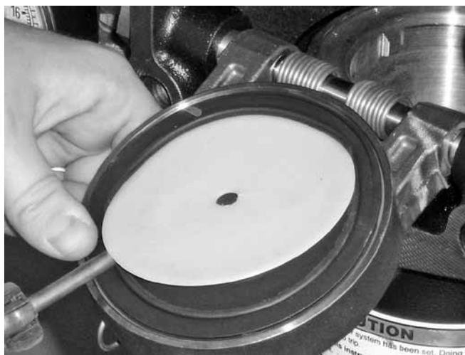
4. Fare leva dall'interno della tenuta del clapet, sotto la rondella della tenuta, dall'interno della tenuta della cerniera, come mostrato in alto. **NON FARE LEVA NEL FORO CENTRALE PER SMONTARE LA RONDELLA DELLA TENUTA.**
