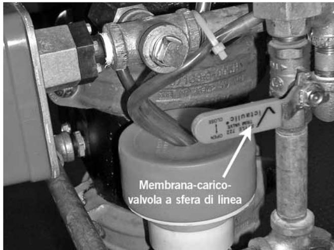
10. Chiudere la membrana-carico-valvola a sfera di linea.
