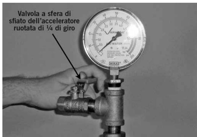
23. **PER SISTEMI INSTALLATI CON ACCELERATORE A SECCO SERIE 746-LPA:** Chiudere la valvola a sfera di sfiato di 1/4 di giro.
