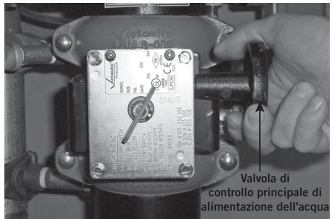
15. Aprire lentamente la valvola di drenaggio principale dell'erogazione di acqua, finché l'acqua non fuoriesce con un flusso costante.
