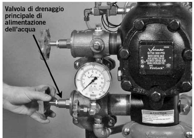
5. Aprire la valvola di drenaggio principale di alimentazione dell'acqua.
