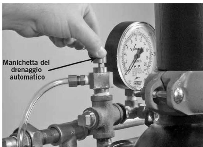
21. Tirare la manichetta del drenaggio automatico finché la vite non è nella posizione impostata ("UP"). Verificare che il manometro indichi la presenza di pressione sulla linea di carico del diaframma.
