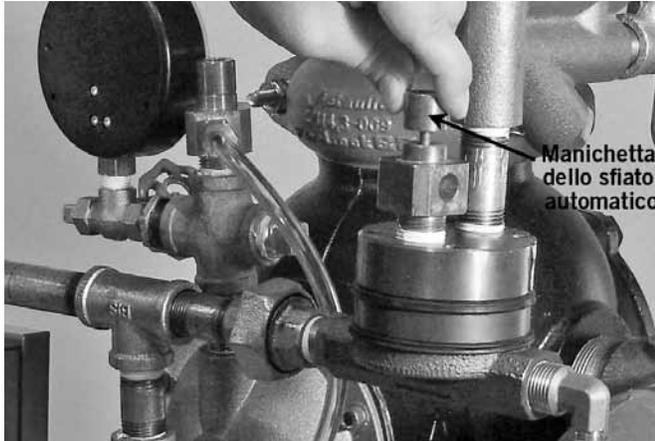
14. **PER SISTEMI INSTALLATI CON ATTUATORE A BASSA PRESSIONE SERIE 776:** Quando il sistema raggiunge circa 10 psi/69 kPa/0,7 bar e lo sfiato automatico non rilascia altra umidità, sollevare il cappuccio dello sfiato automatico dell'attuatore a bassa pressione serie 776. **NOTA:** la vite dello sfiato automatico deve chiudersi e rimanere nella posizione impostata ("UP").
