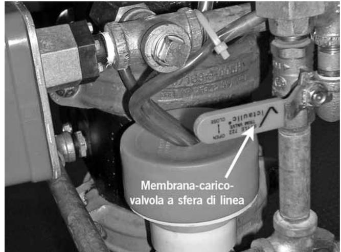
12. Chiudere la membrana-carico-valvola a sfera di linea.
