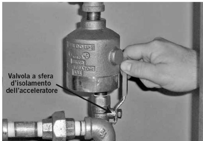
24. **PER SISTEMI INSTALLATI CON ACCELERATORE A SECCO SERIE 746-LPA:** Aprire la valvola sfera di isolamento. In questo modo si regola l'acceleratore.
