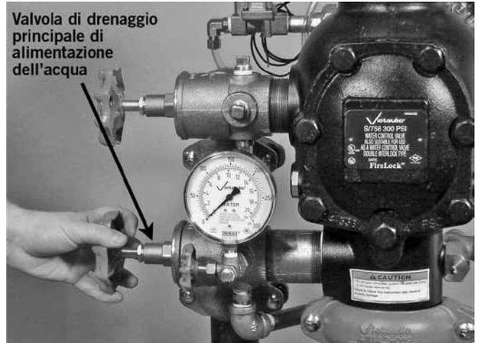
3. Chiudere la valvola di drenaggio principale dell'acqua di alimentazione.
