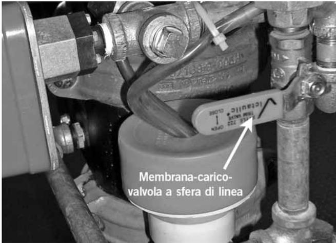
7. Chiudere la membrana-carico-valvola a sfera di linea.
