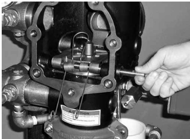
3. Rimuovere l'albero del clapet. **NOTA:** quando si smonta l'albero, la molla del clapet cade. Conservarla per reinstallarla.
