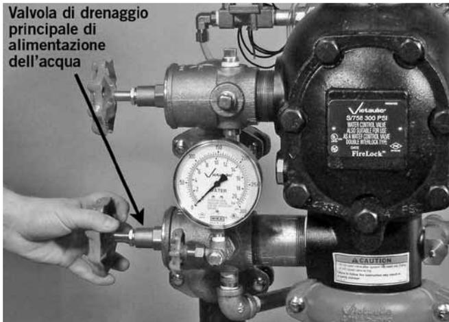
Valvola di drenaggio principale di alimentazione dell'acqua
