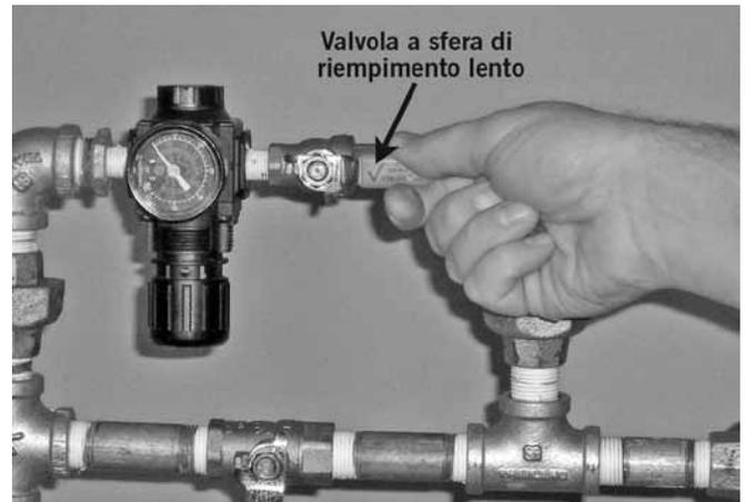
17. Aprire la valvola a sfera di riempimento lento sul dispositivo di mantenimento pressione aria. **NOTA:** se la valvola a sfera di riempimento lento non rimane aperta, la pressione del sistema potrebbe precipitare causando il funzionamento della valvola in caso di perdita del sistema.
