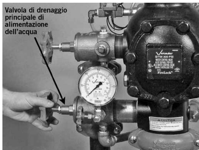
6. Aprire completamente la valvola di drenaggio principale di alimentazione dell'acqua per eliminare eventuali contaminanti dall'acqua di alimentazione.
