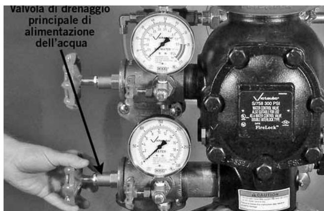
26. Aprire la valvola di drenaggio principale di alimentazione dell'acqua.
