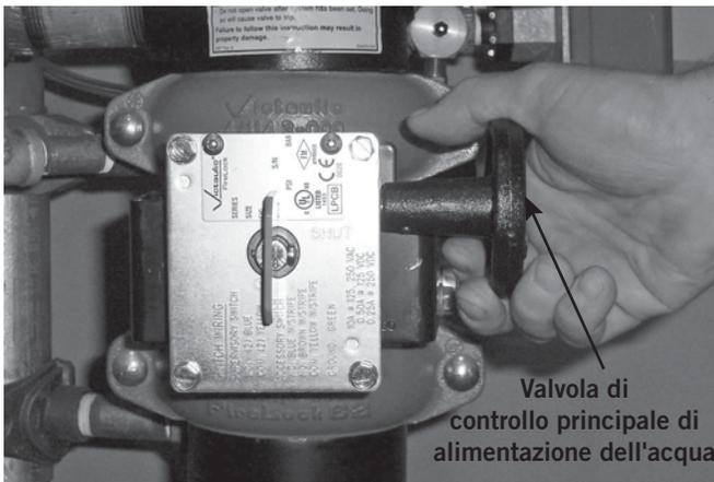
17. Aprire completamente la valvola di controllo principale di erogazione dell'acqua.
