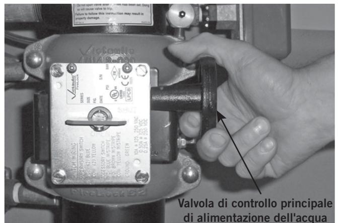
4. Chiudere la valvola di scarico principale di alimentazione dell'acqua per mettere il sistema fuori servizio.
