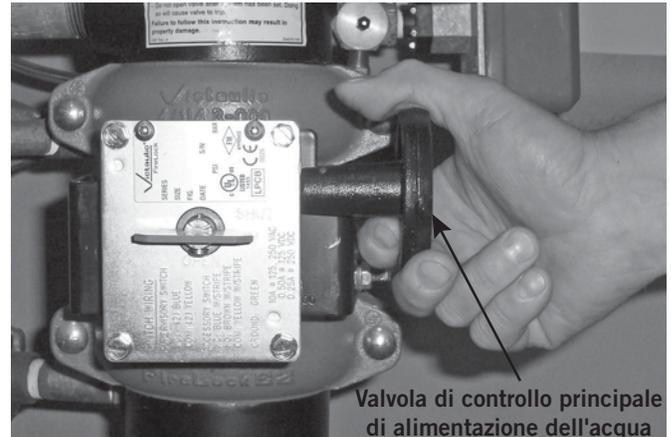
4. Chiudere la valvola di controllo principale dell'acqua di alimentazione fino al punto in cui un'ulteriore chiusura non provoca il flusso attraverso la valvola di drenaggio principale dell'acqua di alimentazione.
