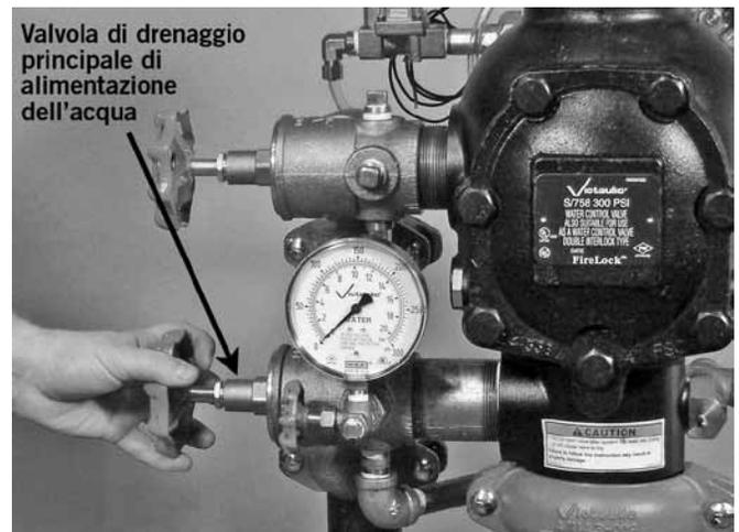
6. Chiudere la valvola di drenaggio principale dell'acqua di alimentazione.
