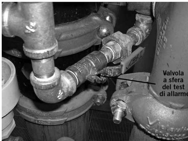
4. Aprire la valvola a sfera del test di allarme. Confermare che sono attivi gli allarmi elettrico e meccanico e che le stazioni di monitoraggio a distanza, se presenti, ricevano un segnale di allarme.
