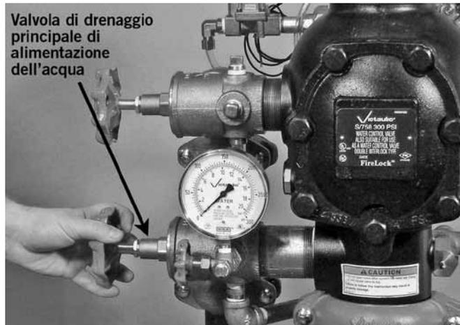
4. Chiudere la valvola di drenaggio principale dell'acqua di alimentazione.
