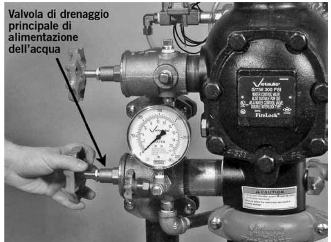
14. Aprire la valvola di drenaggio principale di alimentazione dell'acqua.
