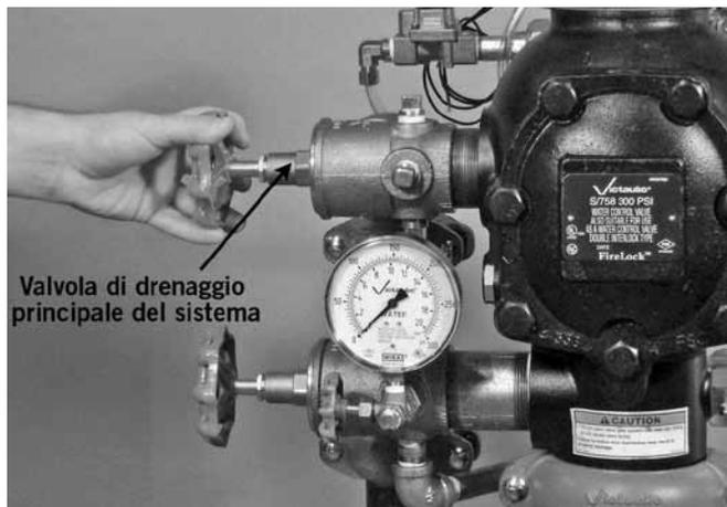
14. Chiudere la valvola di drenaggio principale del sistema.
