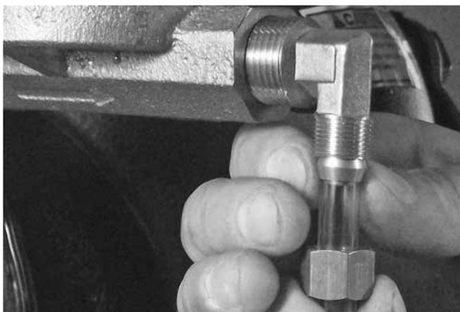
I tubi e i raccordi di compressione sono forniti per il collegamento dall'uscita del drenaggio automatico, dal controllo del gocciolamento e dall'attuatore alla vaschetta di gocciolamento o drenaggio. Questi tubi e raccordi devono essere installati in conformità con il disegno del trim fornito. **NON** inserire mai un tappo sull'uscita del drenaggio automatico, del controllo del gocciolamento e dell'attuatore invece del tubo/raccordo a compressione.
