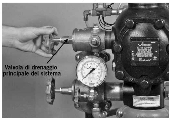
6. Aprire in parte e lentamente la valvola di drenaggio principale del sistema. Confermare che l'acqua non fluisce dal drenaggio. **NOTA:** se l'acqua fluisce dal drenaggio, è possibile che il sistema non sia stato drenato correttamente. In questo caso seguire le istruzioni riportate nella sezione "Messa in servizio del sistema".
