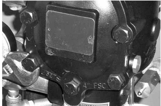
4. Allineare alla valvola la piastra di copertura/guarnizione della piastra di copertura. Controllare che i bracci della molla del clapet siano ruotati in posizione d'installazione. Serrare tutti i bulloni della piastra di copertura nella piastra/nel corpo della valvola.
