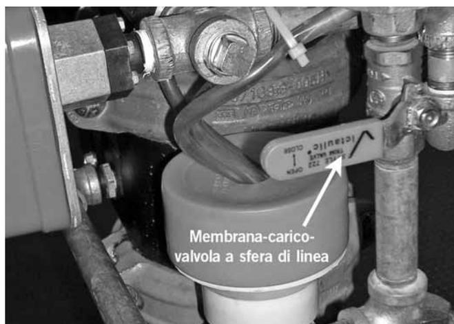
22. Quando la linea di carico del diaframma è pressurizzata, chiudere temporaneamente la membrana-carico-valvola a sfera di linea. Osservare la membrana-carico-manometro di linea per confermare che sulla linea venga mantenuta la pressione.
