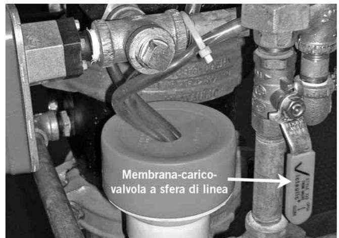
18. Aprire la membrana-carico-valvola a sfera di linea. Lasciare scorrere l'acqua nel tubo del drenaggio automatico.
