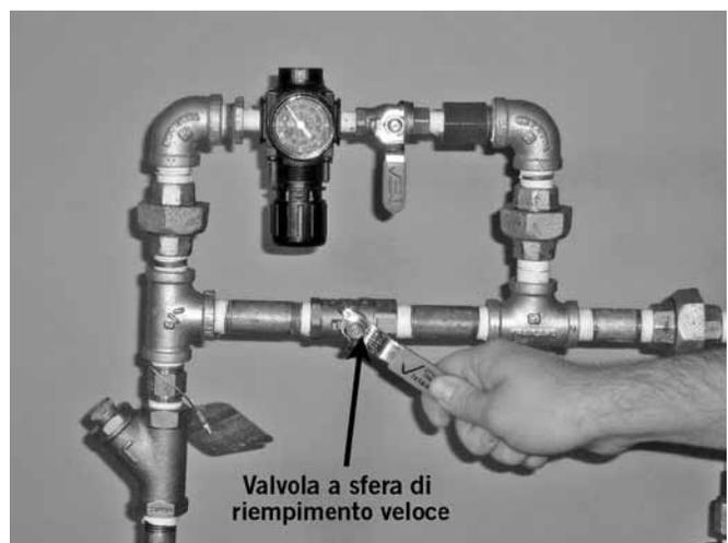
10. Aprire la valvola a sfera di riempimento veloce sull'AMTA. Riportare la pressione sul valore normale per il sistema.
