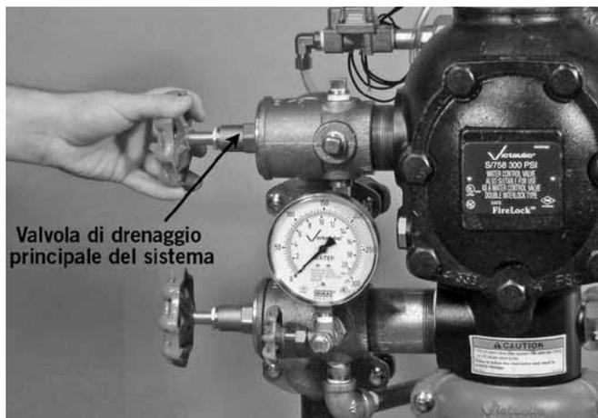
12. Aprire la valvola di drenaggio principale del sistema per drenarlo
