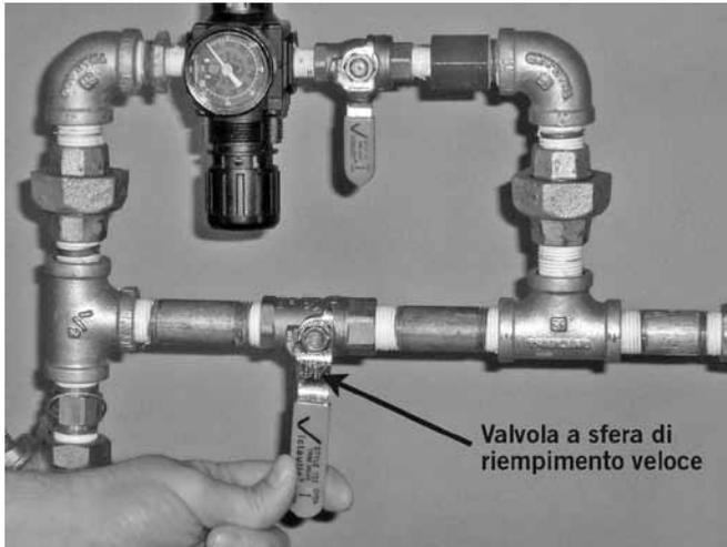
11. Quando la pressione dell'aria di sistema è stabilita sul valore normale, chiudere la valvola a sfera di riempimento veloce sull'AMTA.
