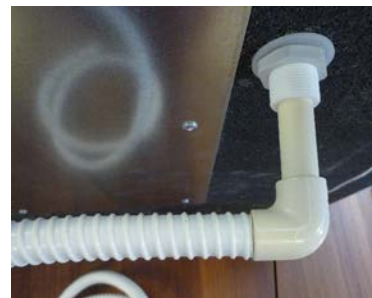
Inserimento del tubo scarico condensa (a carico dell'installatore)
