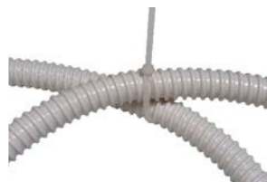
Bloccaggio del tubo mediante fascetta in plastica.
