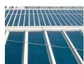
6 Effettuare sempre una movimentazione accurata di attrezzature e materiale durante le lavorazioni sul tetto. Evitare di far strisciare attrezzi e componenti vari sulle lamine o di far cadere elementi metallici taglienti (viti, taglierini, cutter, forbici, punte di trapano, dischi di flessibile, etc.).
