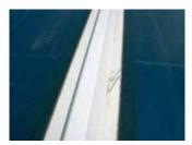
5 Non coprire parti di lamina con lattonerie, attrezzature e materiale vario. L'ombreggiamento totale di parte delle lamine provoca la riduzione delle prestazioni elettriche.
