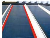
2 Rimuovere accuratamente dalla superficie delle lamine, qualora siano presenti, detriti e sfridi di lavorazioni (spezzoni di lattoneria, viti, rivetti etc.).
