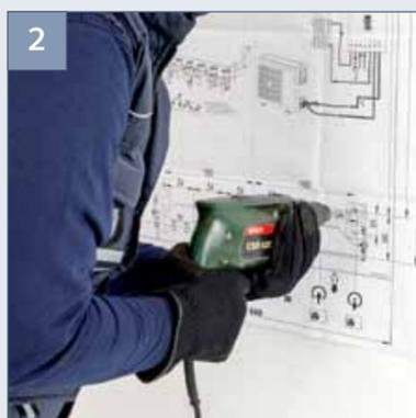
Posizionare sul muro la dima in carta, poi la staffa di aggancio caldaia e il kit barretta.
