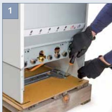
La caldaia viene consegnata, imballata e ancorata su un pallet in legno, con la sonda esterna, il controllo remoto e il tubo corrugato di scarico condensa (forniti di serie). Togliere l'imballo in cartone e sganciare gli elementi di fissaggio al pallet (2 in alto e 2 sul fondo della caldaia).
