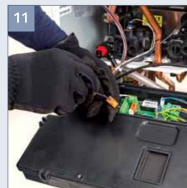
Per accedere alle connessioni delle periferiche, ruotare il pannello comandi in avanti e svitare le tre viti del coperchio posteriore del portastrumenti. Accedere alla scheda per il collegamento delle periferiche: Controllo Remoto, Sonda Esterna, Collegamento Bus per la pompa di calore, Termostato ambiente (opzionale).
