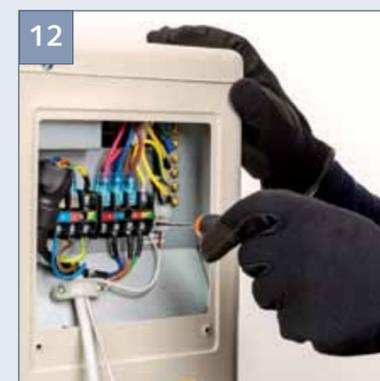
Rimuovere lo sportellino delle connessioni elettriche sulla pompa di calore e procedere al collegamento del cavo Bus e del cavo di alimentazione elettrica della pompa di calore.
