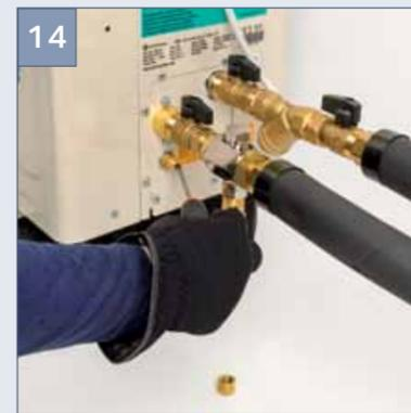
Durante il ciclo di disareazione, aprire la valvola di sfogo aria della pompa di calore dopo aver rimosso il tappo. Inoltre, disareare tramite la specifica valvola di sfogo anche lo scambiatore primario della caldaia. Verificare che l'indicazione della pressione d'impianto sull'idrometro sia di 1,2 bar. Se necessario, ripristinare la pressione dell'acqua del circuito.
