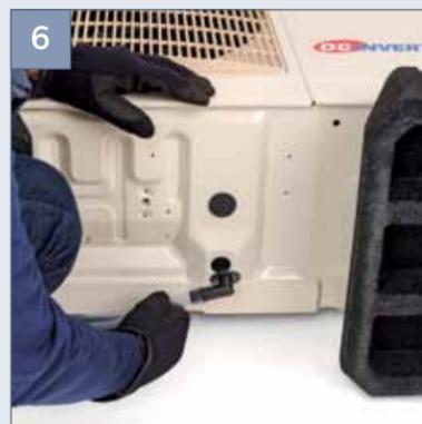
Disimballare la pompa di calore rimuovendo il cartone, le protezioni in polistirene e il film di plastica. Installare i piedini antivibrazione e il tubo di evacuazione della condensa forniti come accessori all'interno dell'imballo.
