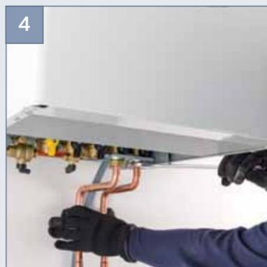
L'elevata efficienza energetica della caldaia produce condensa che deve essere smaltita. A tal fine utilizzare una tubazione in plastica. Prima della messa in servizio, il sifone deve essere riempito d'acqua per evitare la fuoriuscita dei fumi di scarico nell'ambiente. Versare circa 1/4 di litro dallo scarico dei fumi prima di procedere al raccordo dei condotti scarico/aspirazione o svitare il sifone posto sotto la caldaia, riempirlo e riposizionarlo.
