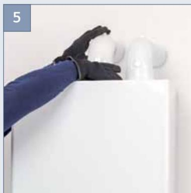
La caldaia deve essere installata solo se provvista di un dispositivo d'ingresso aria e di uscita dei fumi (forniti separatamente dall'apparecchio). La caldaia è predisposta per il collegamento a un sistema di aspirazione e di uscita dei fumi di tipo coassiale. In caso di configurazione coassiale, i condotti devono avere una pendenza discendente (3%) verso l'apparecchio per evitare ristagni di condensa.
