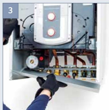
Agganciare la caldaia alla staffa, rimuovere il mantello frontale, svitare le due viti di sostegno e rimuovere la lamiera alla base della caldaia per liberare i raccordi, raccordare rubinetti e raccordi della barretta idraulica alla caldaia.
