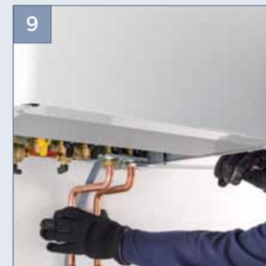
Connettere i tubi da 3/4" di mandata alla pompa di calore e da 3/4" di ritorno dalla pompa di calore. A seguire, connettere il tubo da 3/4" di ritorno dall'impianto di riscaldamento, quello da 1/2" dell'entrata dell'acqua fredda, il tubo da 3/4" della tubazione del gas, il tubo da 1/2" dell'uscita dell'acqua calda e infine il tubo da 3/4" di mandata dall'impianto di riscaldamento.
