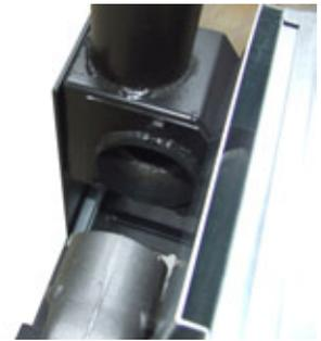
5) Se necessario pulire anche il raccordo fumi con l'aspiratore
