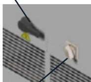
Sezionatore della connessione ai pannelli fotovoltaici
