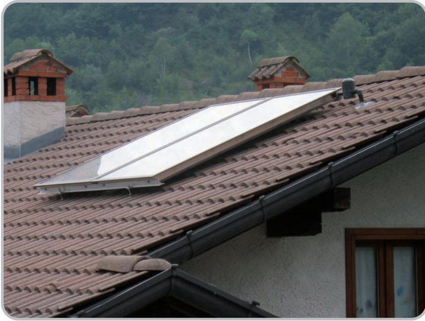
parallelo al tetto
