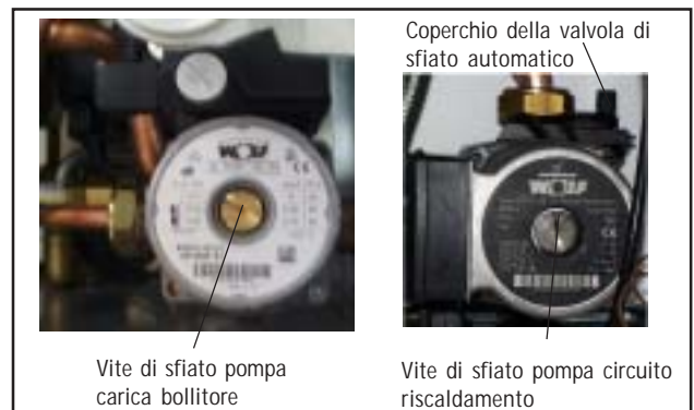
Figura: valvola di sfiato sulla pompa circuito riscaldamento e sulla pompa carica bollitore
