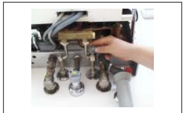
Figura: caldaia con produzione acqua sanitaria
